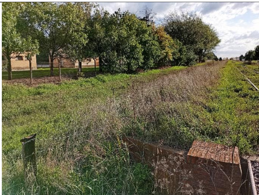
Avenida del Molino al 2200 (cuneta del ferrocarril y puente)
