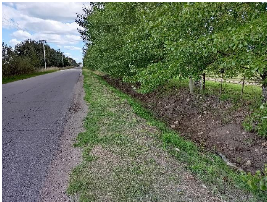
Camino Luis Salvi (cuneta aledaña al Barrio Polo Club, insuficiente)
