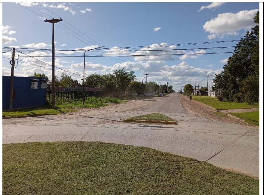
La Avenida Libertad en su inicio (cunetas anuladas y cordón cuneta)
