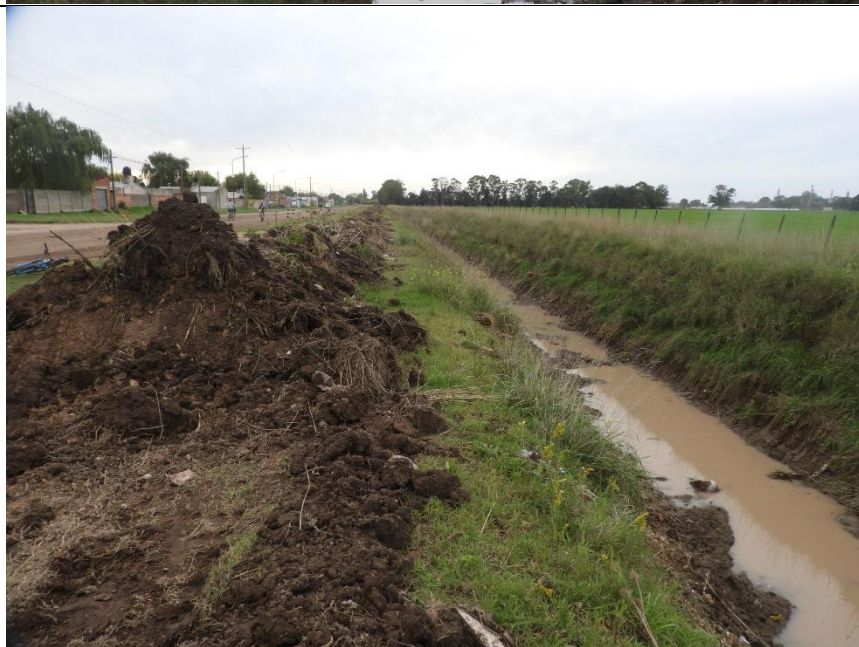
Mismo canal a su paso por el Barrio Islas Malvinas
