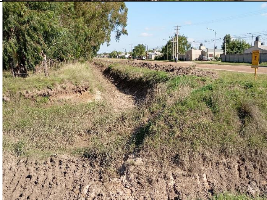
Mismo canal desembocando en el canal de la Avenida Olavarría
