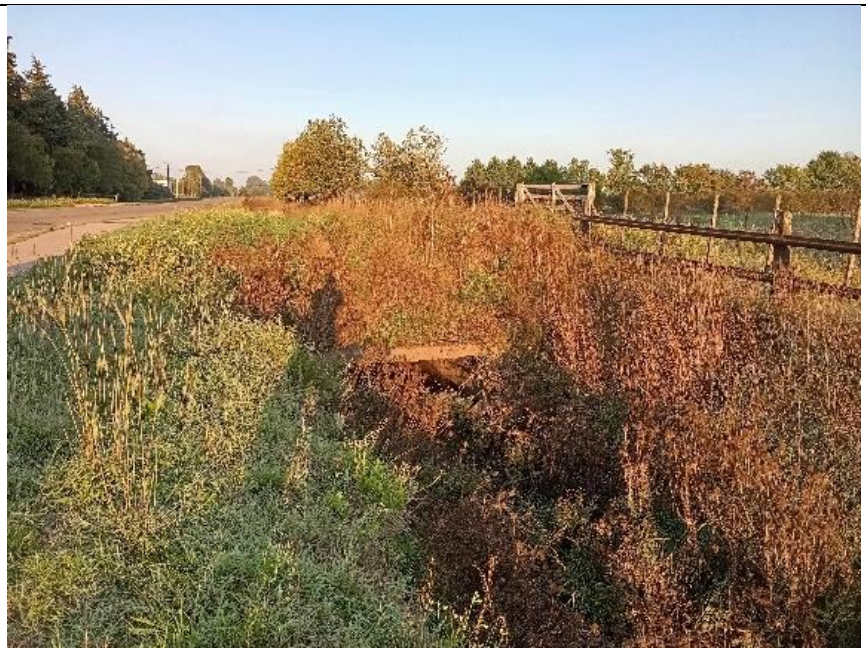
Canal abierto de Avenida Alfonsina Storni, cruce con vías del FFCC Mitre
