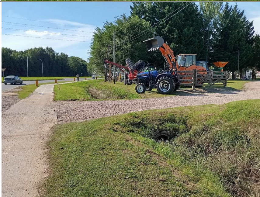
Avenida Alemanes del Volga entre Santa Trinidad y Coronel Suárez (acequias insuficientes)
