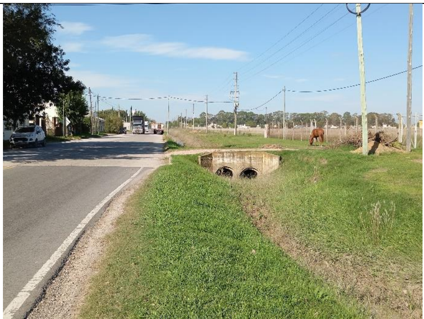
Canal de Avenida Olavarría, acceso a planta de gas (dos tubos de 1,00 m de diámetro)
